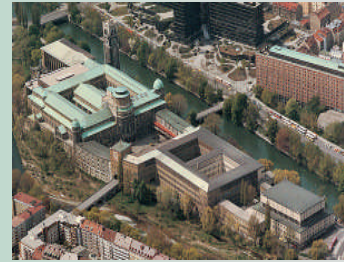
Museo de Munich (ALEMANIA) Aislamiento realizado en la cubierta de 7000 m 2 , con un espesor de 20 cm. Consiguiendo un ahorro energético de 75.000 L. fuel-oil por año y una reducción de emisión de CO 2 de 180 Toneladas.
